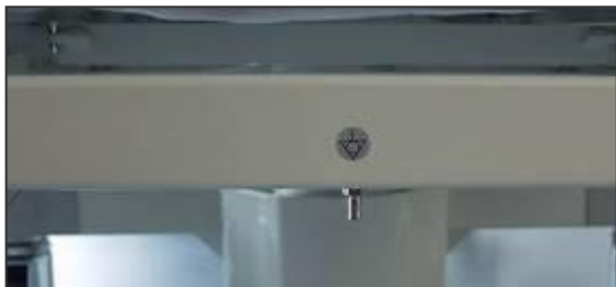
Fig. Connettore per l'equalizzazione – maschio
